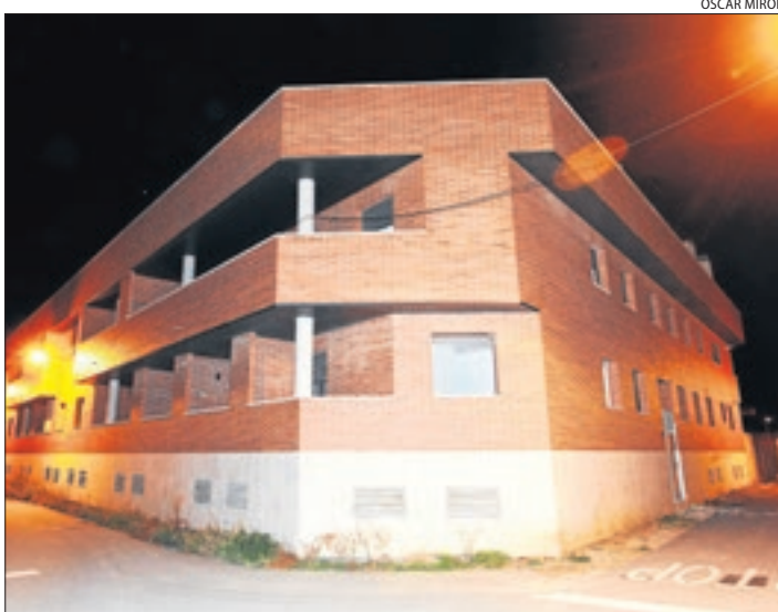
Vista de la promoción a medio construir en Torrelameu.
